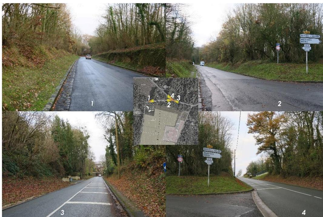
Les voies sur la partie située dans la pente du coteau présentent en outre la caractéristique géométrique d'être insérées en creux par rapport au terrain naturel avec par endroit une différence de niveau de plus de 3m en dessous des zones boisées, accentuant la discontinuité des passages pour la faune terrestre.
